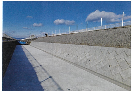
龍舞地区水路改修工事
