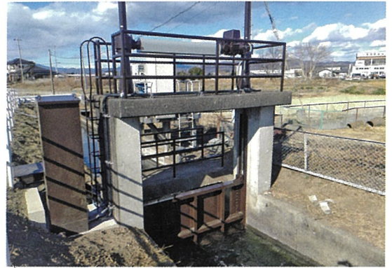
矢場川放水工整備工事
