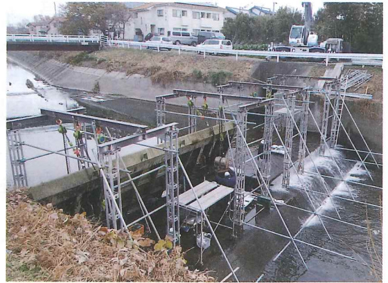
四ヶ村堰地区 転倒ゲート整備工事状況
