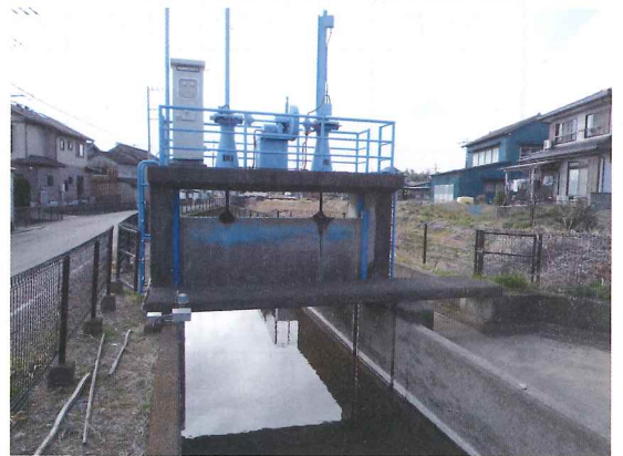
新田堀幹線地区 大鷲堰整備工事
