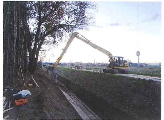
長堀地区 防護柵改修状況
