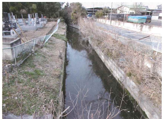
仲伊谷田地区 防護柵改修工事
