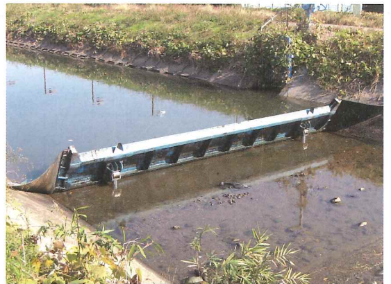
石堰地区 転倒ゲート整備工事
