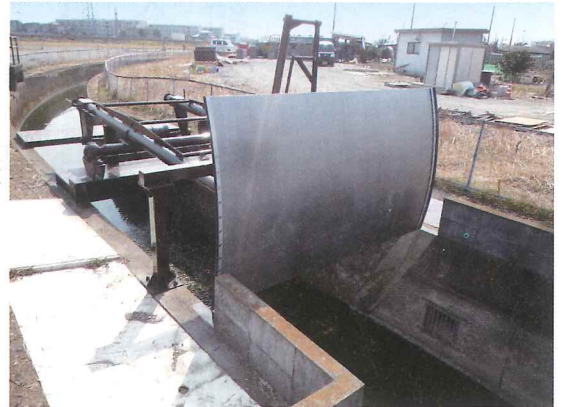
矢場幹線地区 植木野堰・沖堰整備状況
