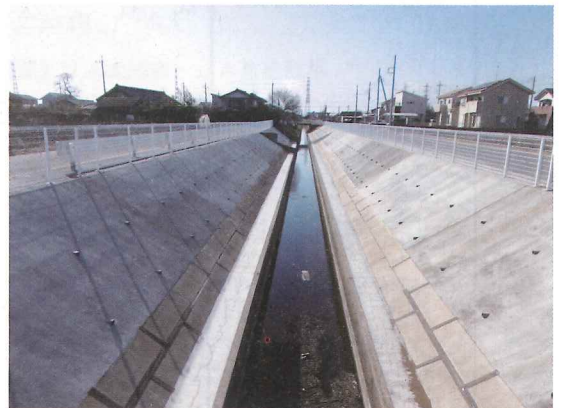
長堀地区 防護柵改修状況
