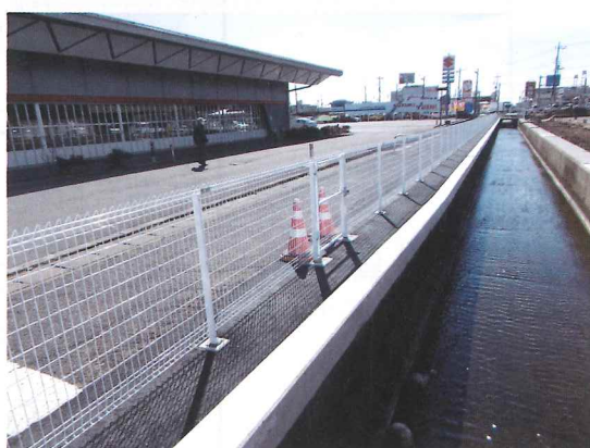
大谷幹線地区 防護柵改修工事
