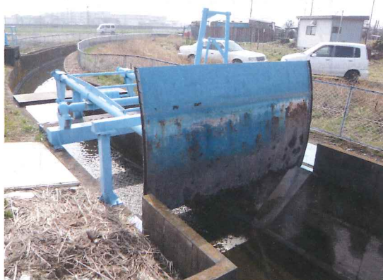
矢場幹線地区 植木野堰・沖堰整備工事
