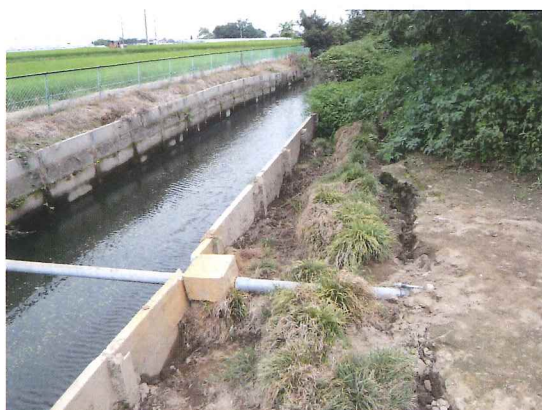
仲伊谷田地区 水路改修工事
