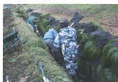
水路の泥上げ
