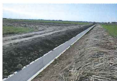
水路の更新（長寿命化）
