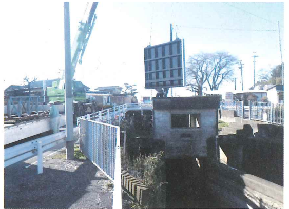
余水吐制水門地区 ゲート据付状況
