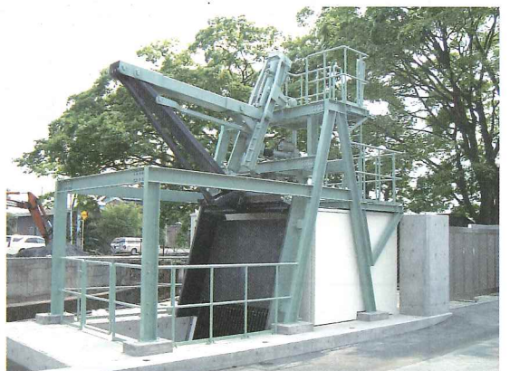
新田堀幹線地区 除塵機整備工事
