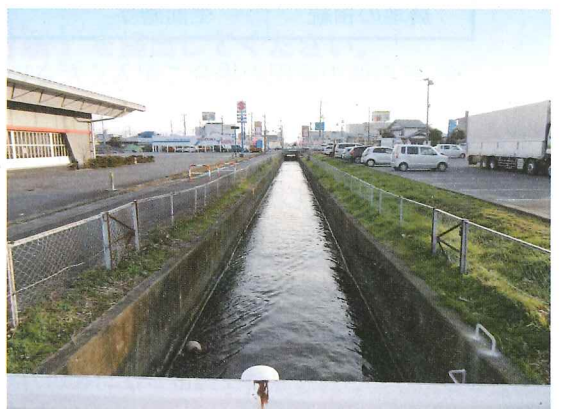
大谷幹線地区 防護柵改修工事
