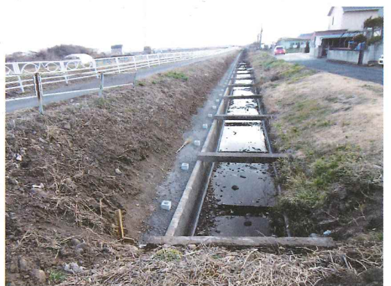
田島堀地区 防護柵改修工事
