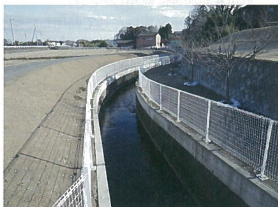
台之郷地区 防護柵改修工事
