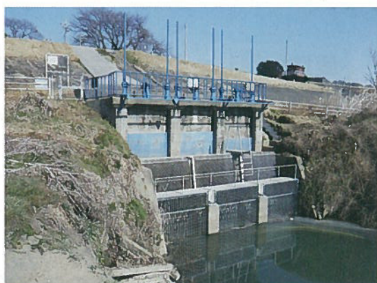
古海地区 取水ゲート整備工事
