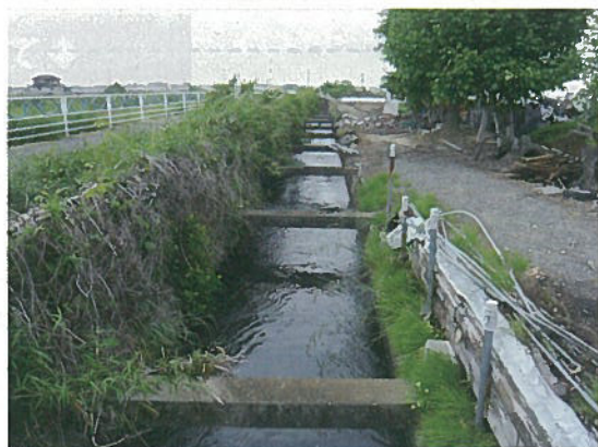
田島堀地区 防護柵改修工事
