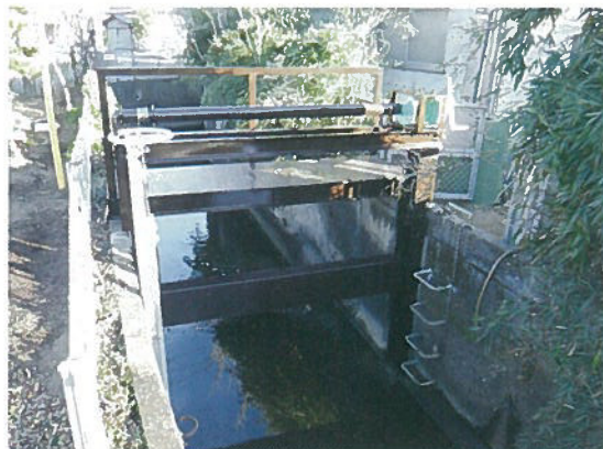
東今泉地区 水門設置工事
