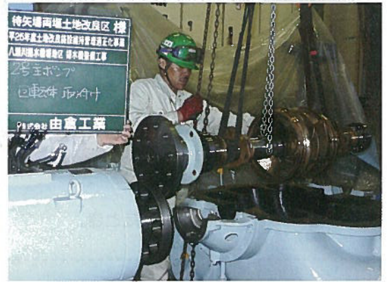
八瀬川揚水機場地区 揚水機整備工事
