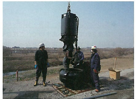
古海地区 揚水機修繕工事
