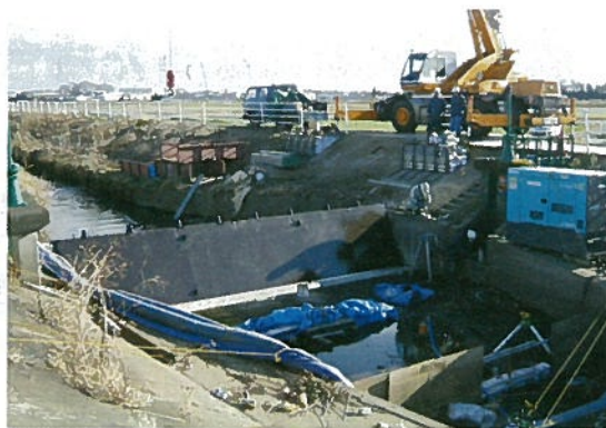
入ヶ谷堰整備工事
