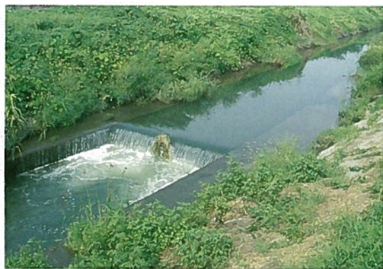
赤堀堰地区 転倒ゲート
