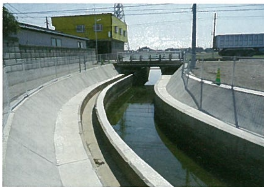
藤川地区防護柵改修工事
