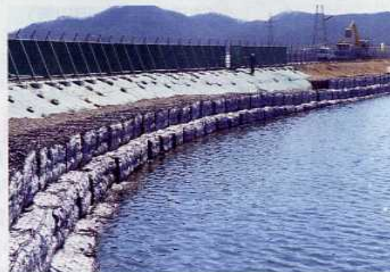
阿左美東地区 堤体復旧工事
