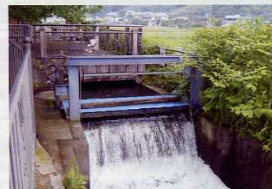
大谷一号堰改修工事
