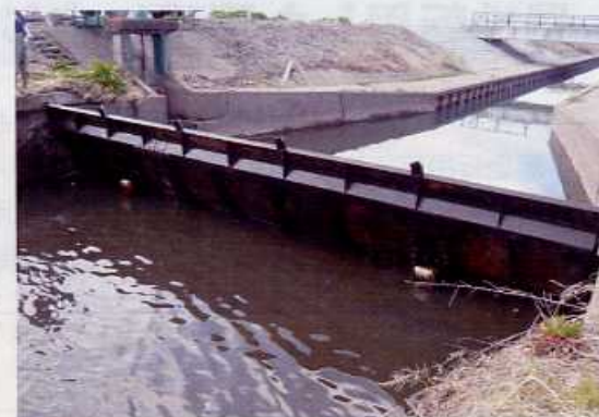
入ヶ谷堰整備工事
