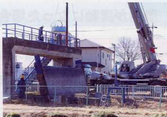
諏訪堰整備工事
