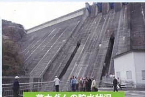
草木ダムの貯水状況
