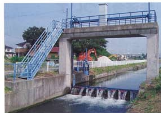
諏訪堰 ゲート整備工事
