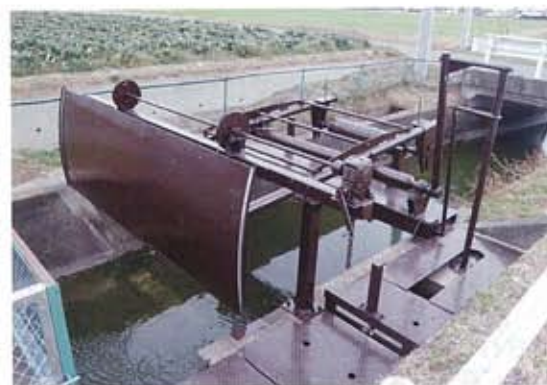
富若大堰 ゲート整備工事
