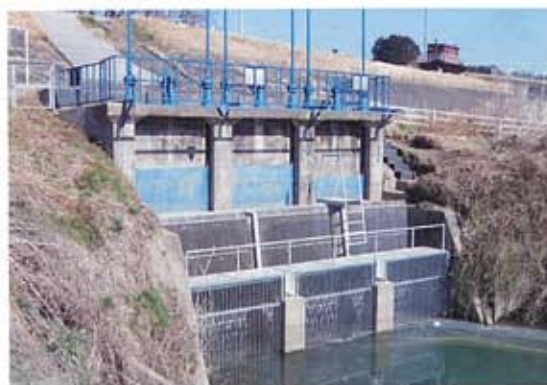
古海揚水機場 スクリーン整備補修工事
