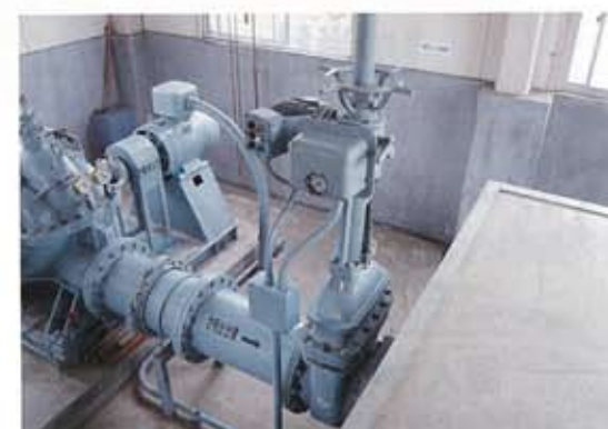
八瀬川揚水機場 揚水機改修工事(バルブ交換)
