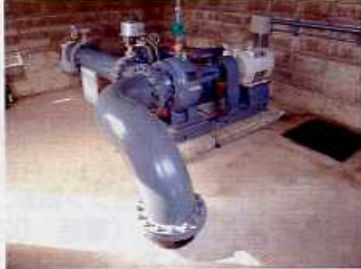
八丁揚水機場整備工事
