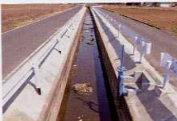
太田市船屋町他 田島堀護岸改修工事
