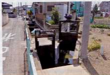
太田市西野谷町 ゲート設置工事
