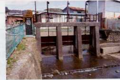
新田堀幹線地区 下馬堰整備工事
