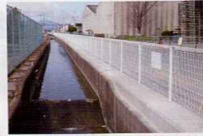
東新町地区 防護柵改修工事
